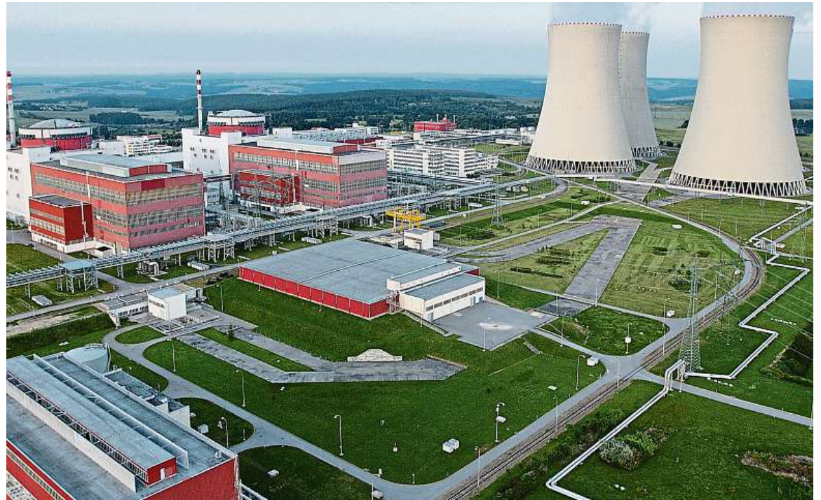
Potrubi Po okraji areálu Temelína se klikatí potrubi dodávající teplo do nedalekého Týna nad Vltavou. Foto: ČEZ
