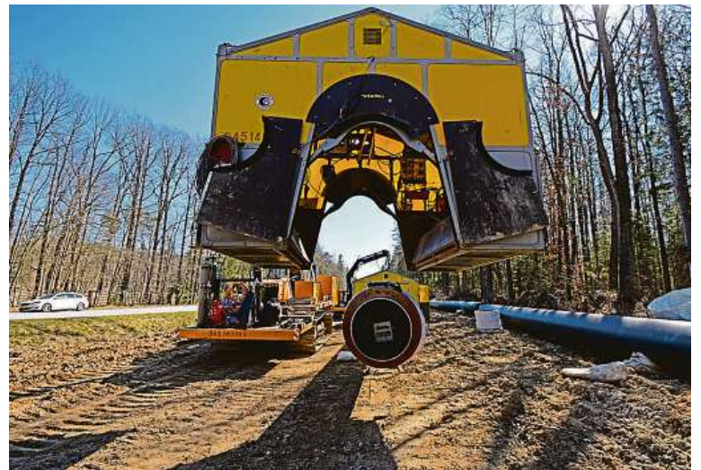
Z Temelína do Českých Budějovic Dokončování stavby horkovodu. Foto: ELTE
