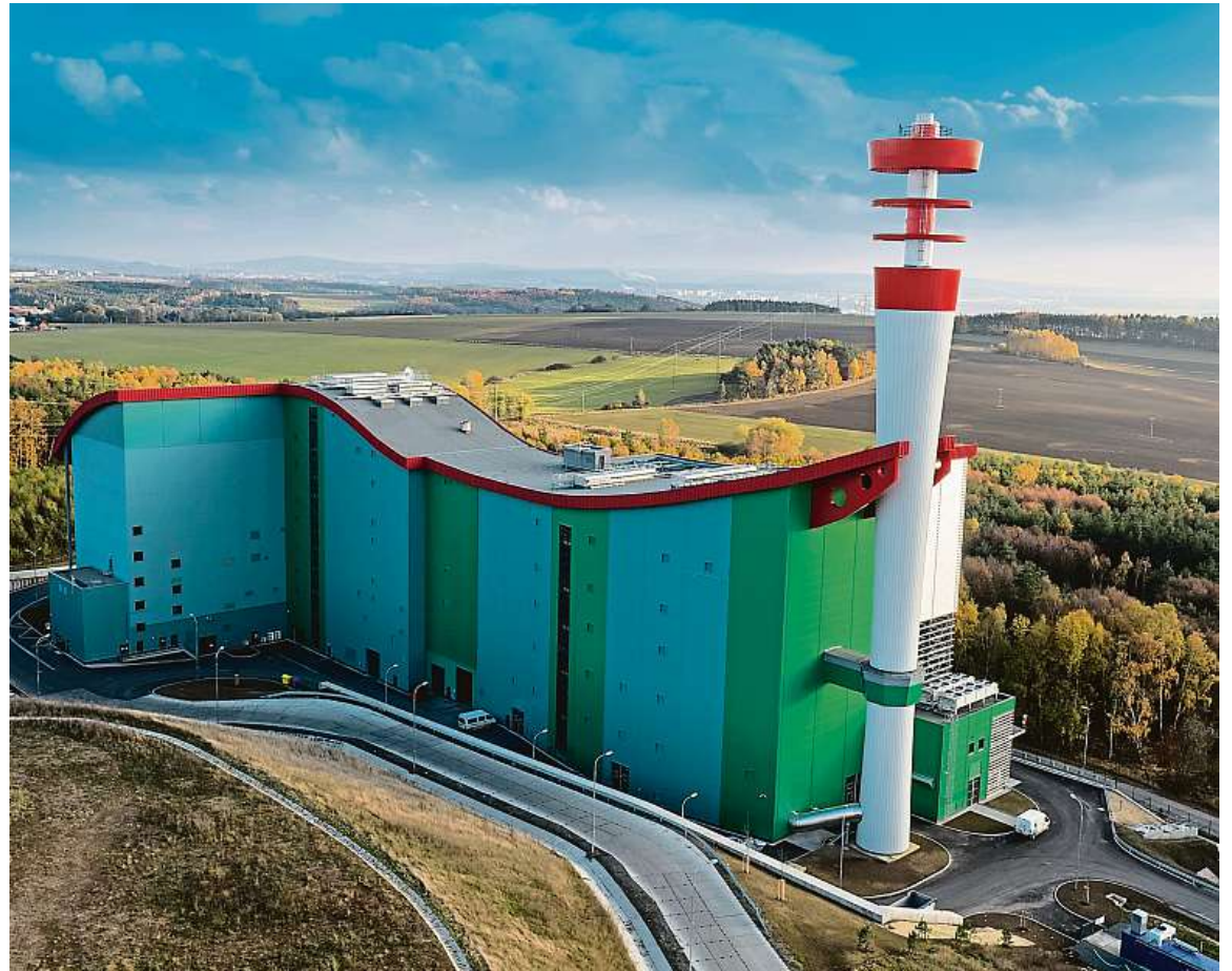
Zařízení pro energetické využití odpadu Plzeňské teplárenské v Chotíkově.
