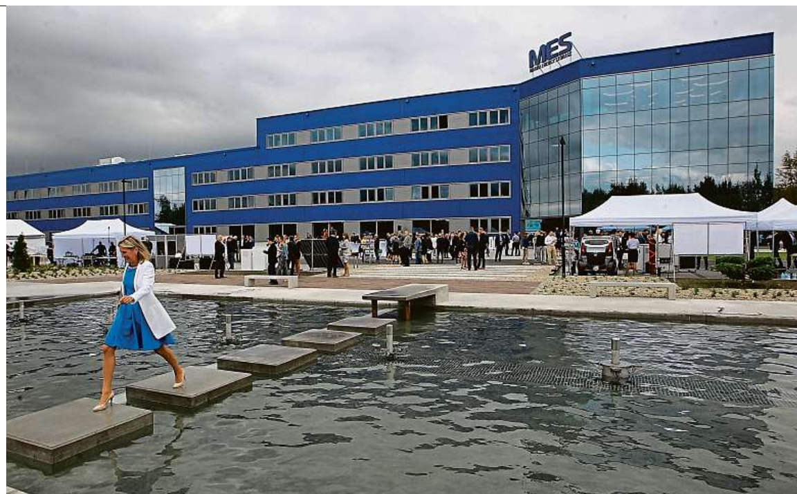
Výroba baterií V nové továrně Magna Energy Storage v Horní Suché se vyrábějí nejmodernější baterie třeba pro elektromobily nebo energetické banky. Projekt vychází z celosvětově registrovaného patentu Jana Procházky, který je prezidentem firmy. Foto: Alexandr Satinský, MAFRA
